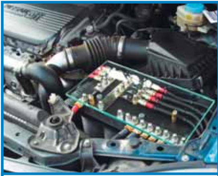
Handgefertigt: eine solide Stromverteilung sorgt im Nissan Almera für verlustarme Versorgung der Komponenten
